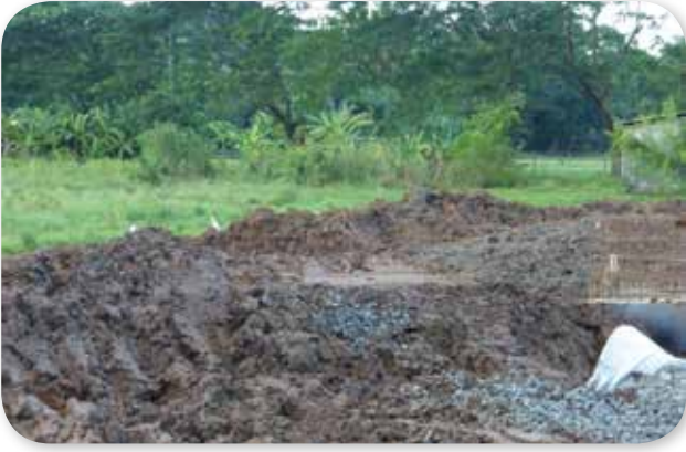
Travaux en zone humide © Caroline Cremades
