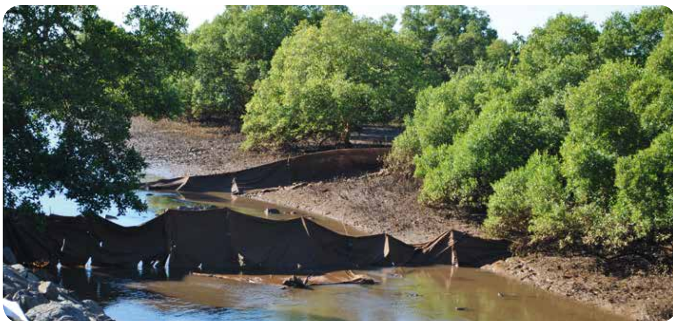
Barrage filtrant lors de travaux en rivière © Caroline Cremades
