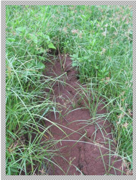
▲ Creusement de drainage en cours
