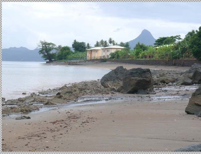
▲ Construction d'une école derrière enrochement
