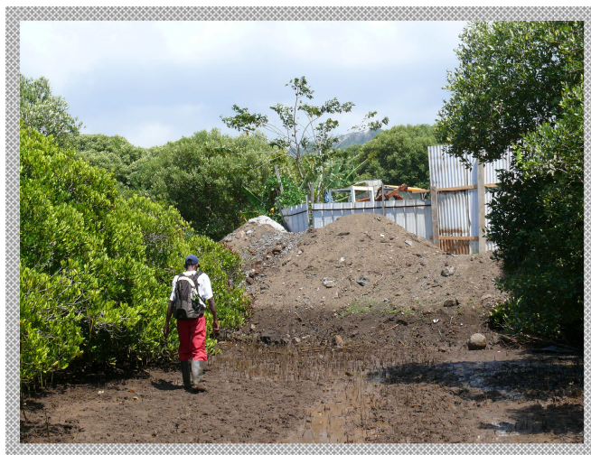
▲ Remblais sur mangrove
