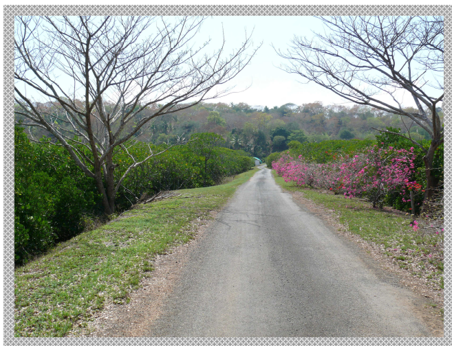
▲ Accès bitumé qui traverse la mangrove
