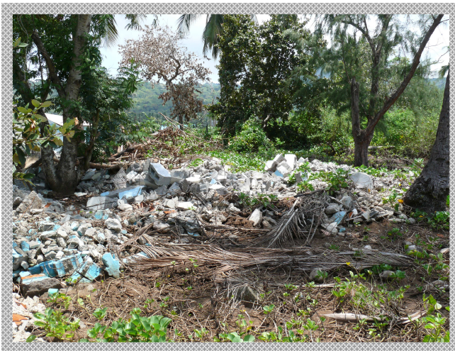
▲ Remblais sur berges du Mroni Amanana
