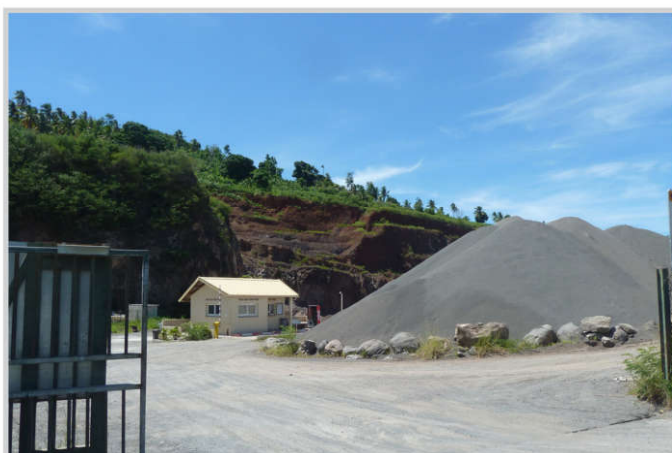
Des plaies ouvertes dans le paysage qu'il conviendra d'intégrer par des aménagements paysagers
