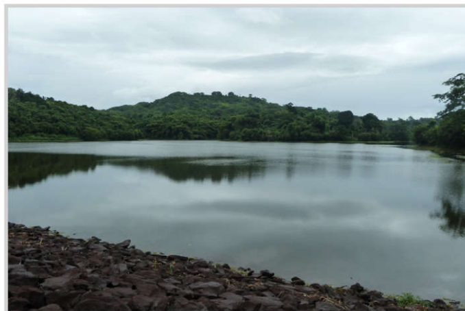
Retenue collinaire de Combani
