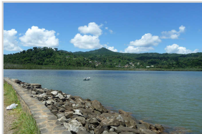
Un trait de côte entre mangrove et aménagement minéral au niveau de Chiconi
